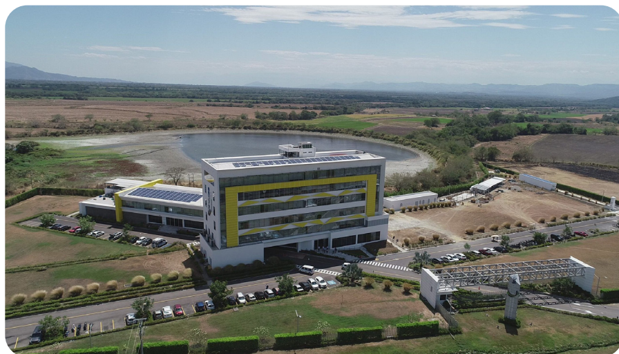
Figura 11. Fachada de la Clínica Internacional de Alta Tecnología en Cáncer
